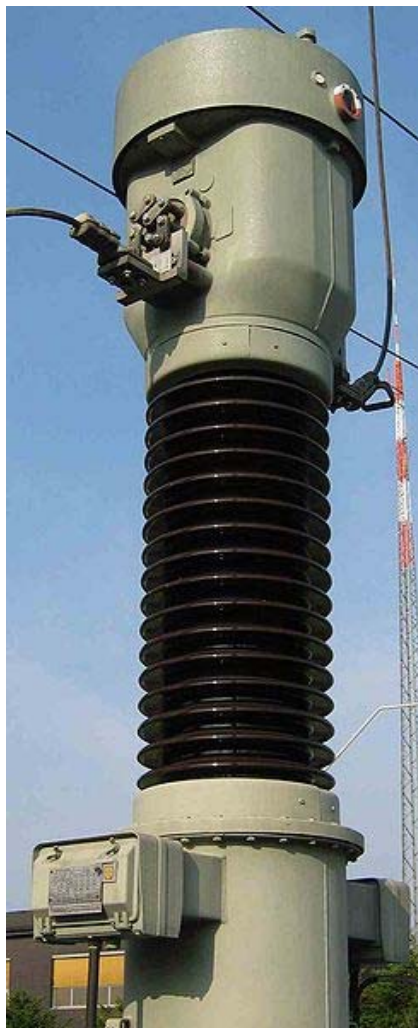
Przekładnik prądowy w sieci 110kV
